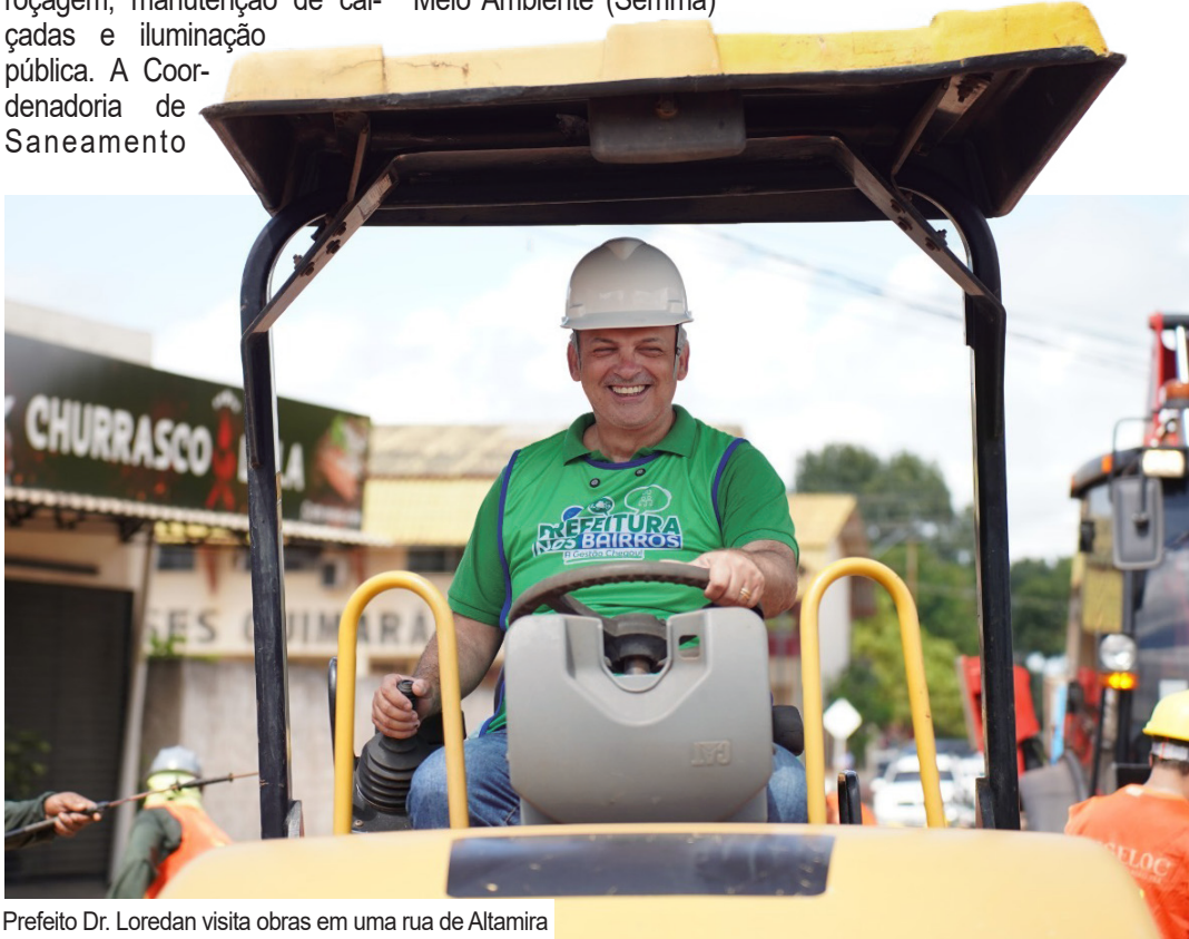
Prefeito Dr. Loredan visita obras em uma rua de Altamira
