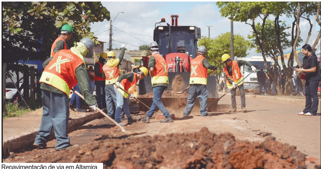
Repavimentação de via em Altamira
